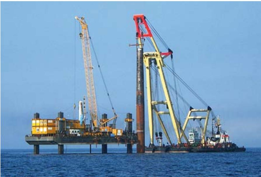
Abb. 9/10: Fertigung Monopile onshore / Rammung Monopile
