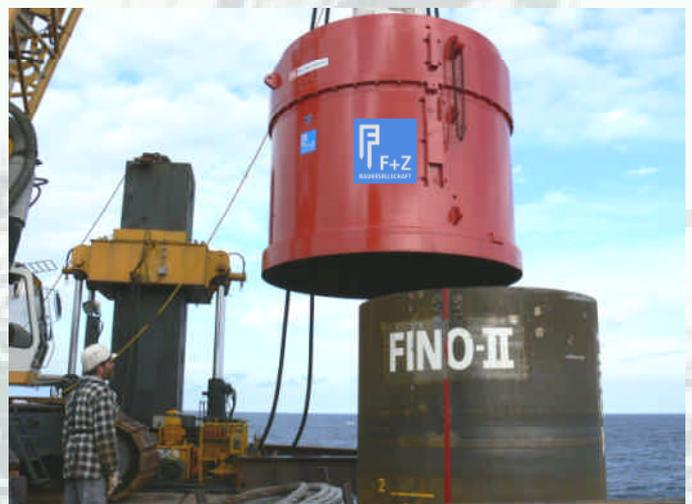
Pfahlrammung mit Hydraulikbär IHC S-500
